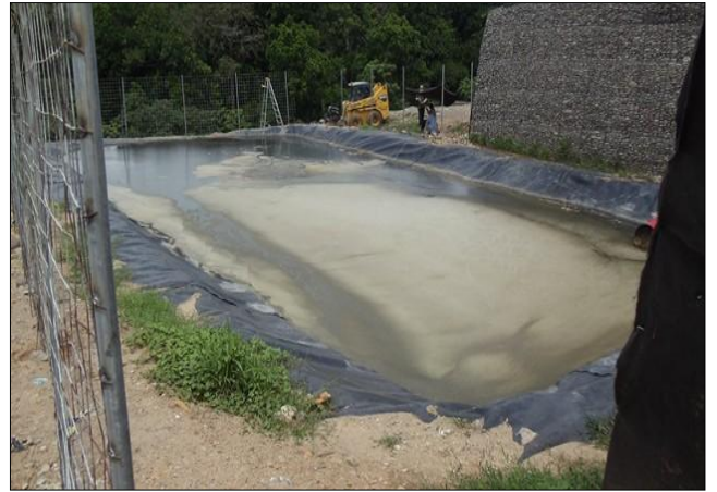
Fig 2. Laguna de lixiviados
