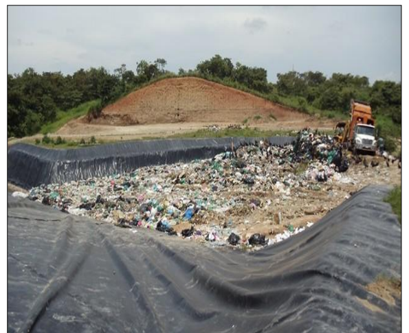
Fig 9. Celda con geomembrana
