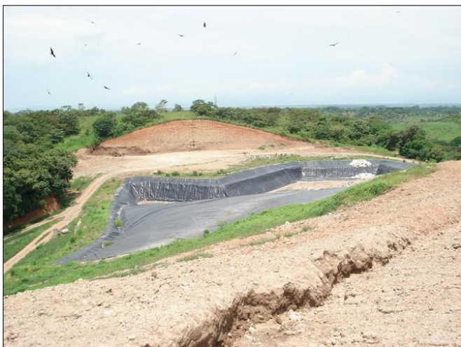
Fig 8. Celda con geomembrana
