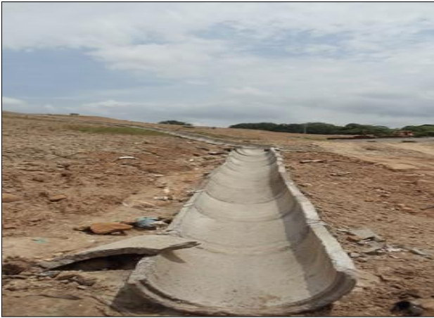
Fig 1. Canales para agua pluvial
