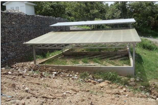
Fig 3. Piletas de lixiviados
