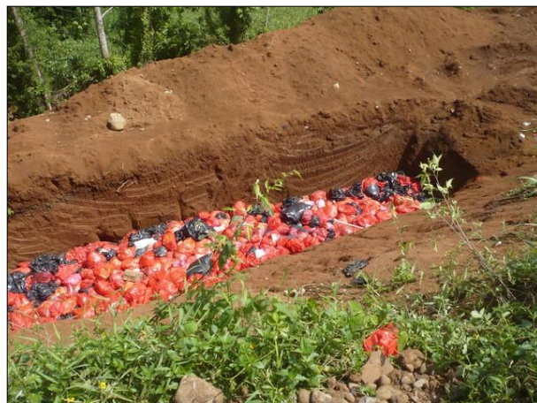
Fig 6. Celda de residuos especiales.
