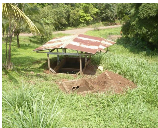
Fig 7. Pileta rústica de lixiviados.
