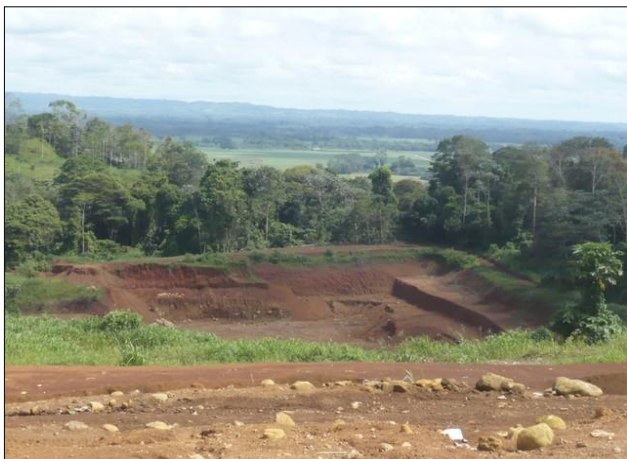
Fig 3. Celda en construcción.
