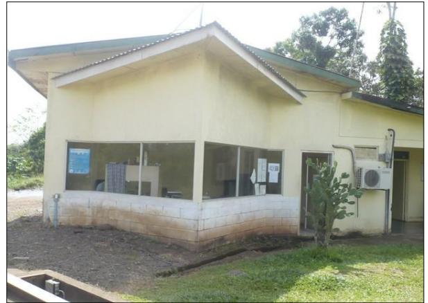
Fig 2. Caseta de vigilancia.
