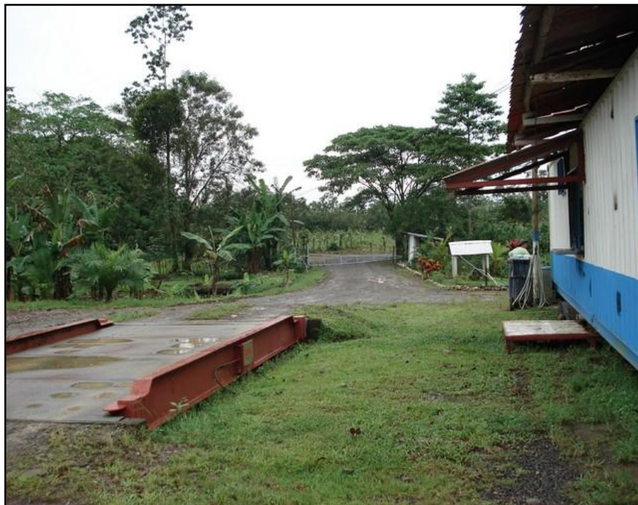
Fig 1. Entrada y romana para pesaje de camiones.
