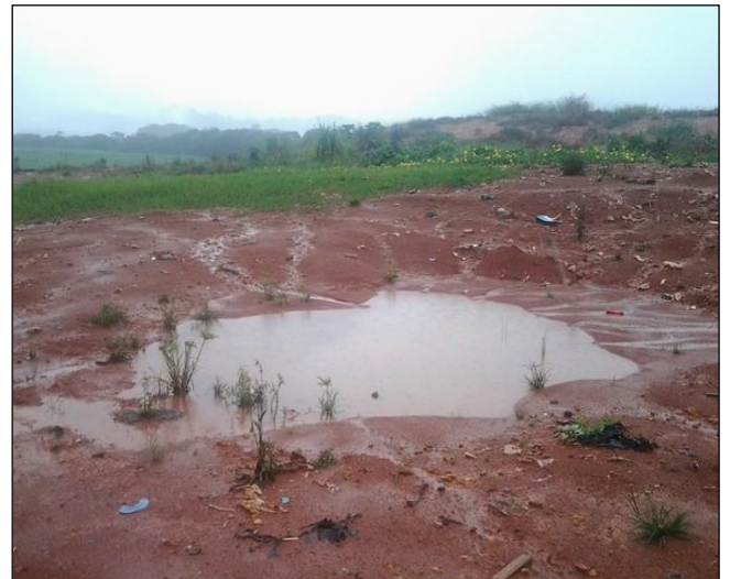
Fig 2. Parte nueva del vertedero saturada de agua
