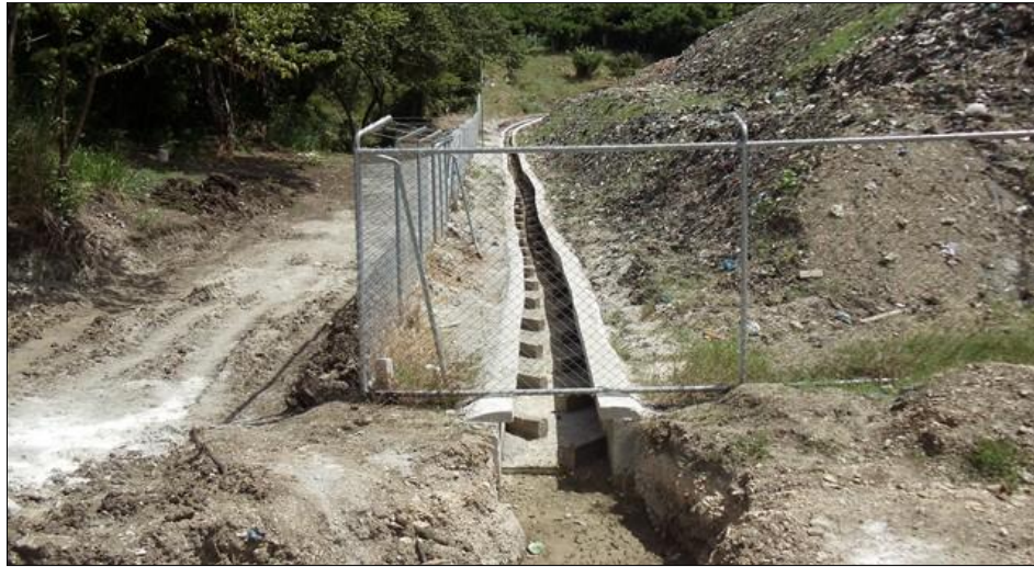
Fig 1. Canal recolector de agua pluvial colindante al vertedero.
