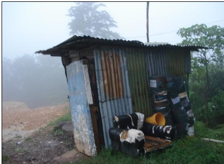
Fig 1. Caseta de vigilancia
