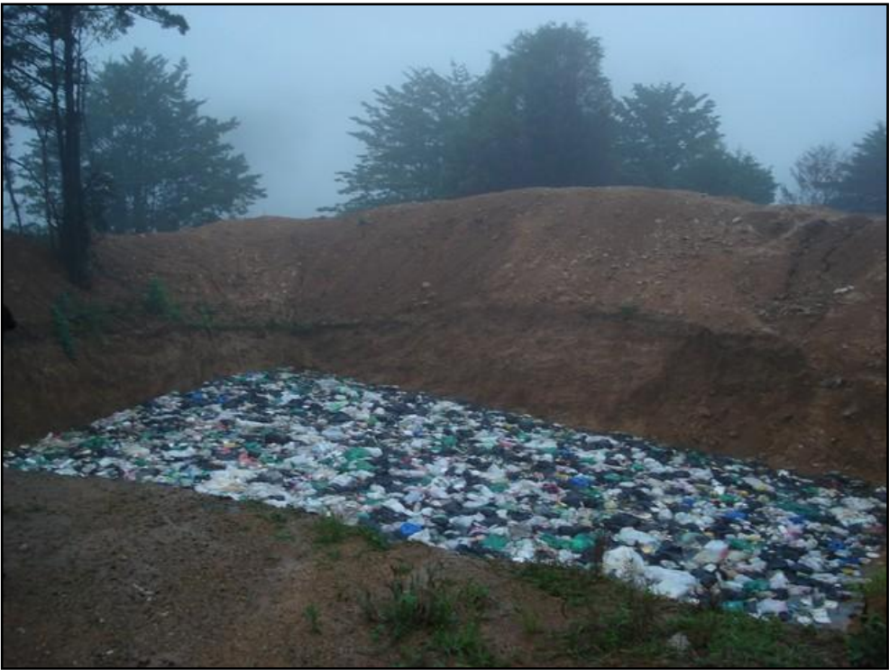
Fig 8. Celda en funcionamiento
