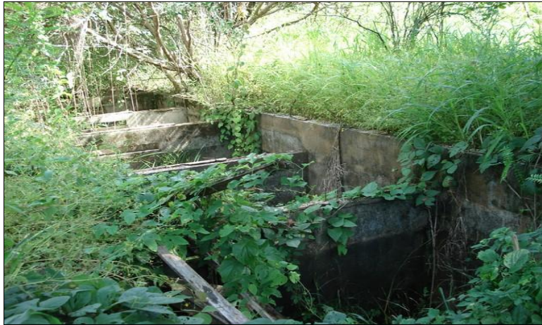
Fig 4. Pileta de lixiviados en vertedero cercano.
