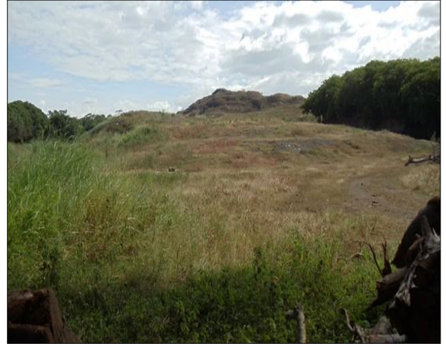
Fig 2. Vista del vertedero.
