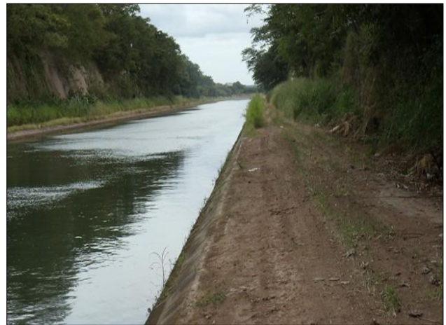
Fig 4. Canal Oeste de SENARA.
