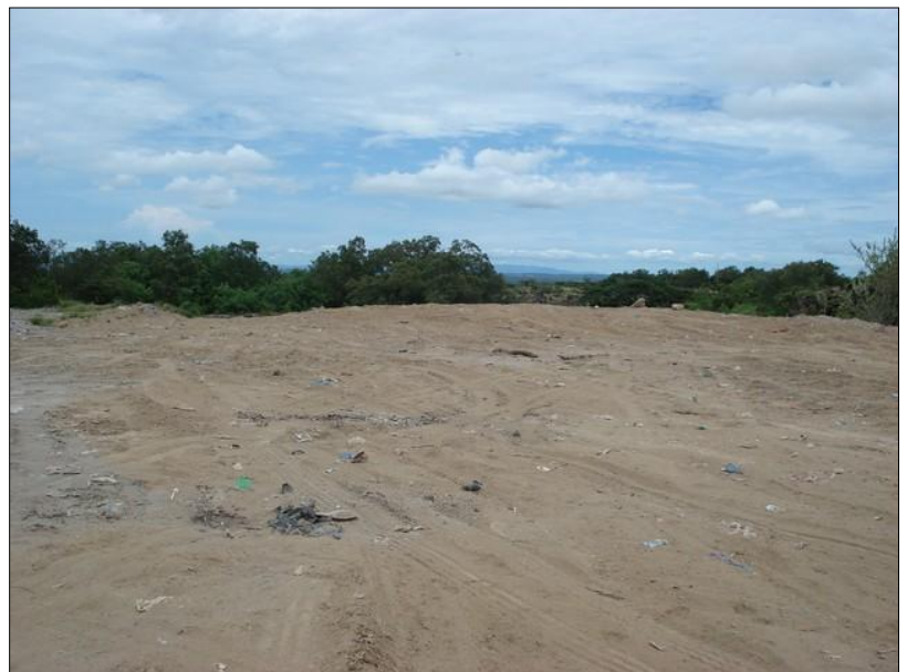
Fig 5. Celda cubierta con tierra.
