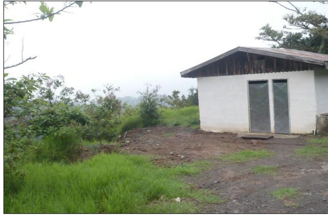
Fig 4. Caseta de control.
