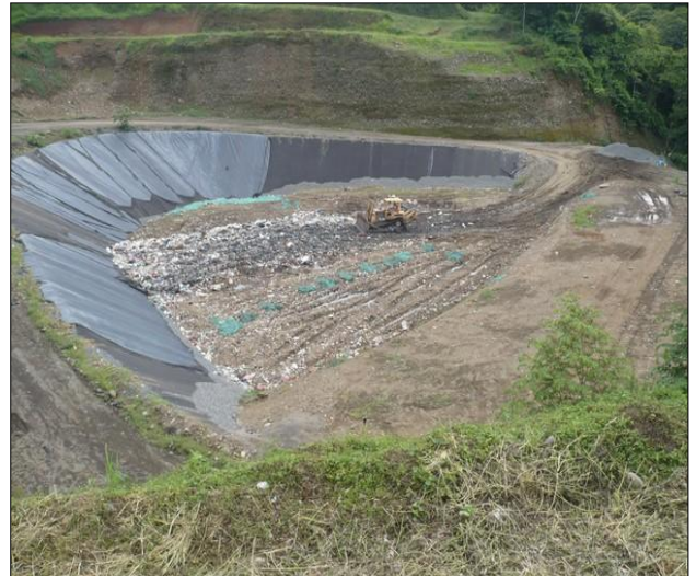
Fig 2. Celda utilizada cubierta con geotextil
