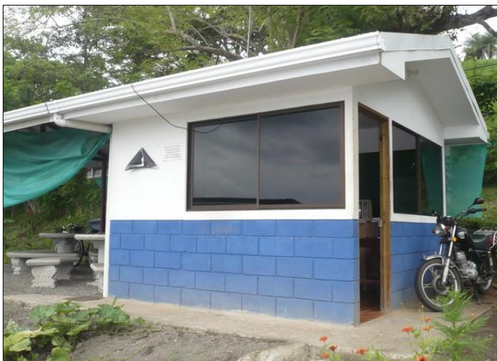
Fig 7. Caseta de vigilancia en entrada al Relleno
