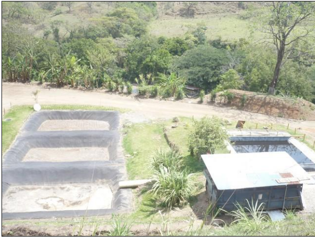
Fig 7. Planta de tratamiento.
