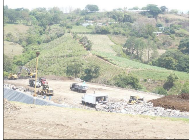
Fig 2. Celda en funcionamiento.
