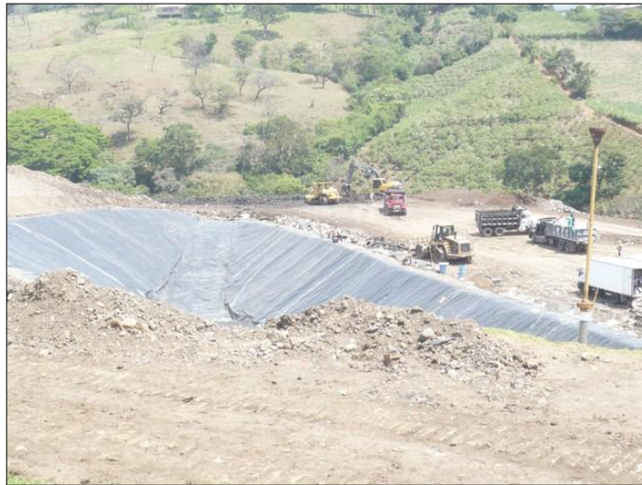
Fig 3. Celda en construcción.
