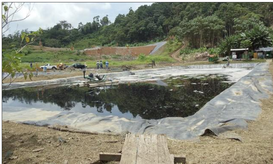
Fig 3. Planta de lixiviados.
