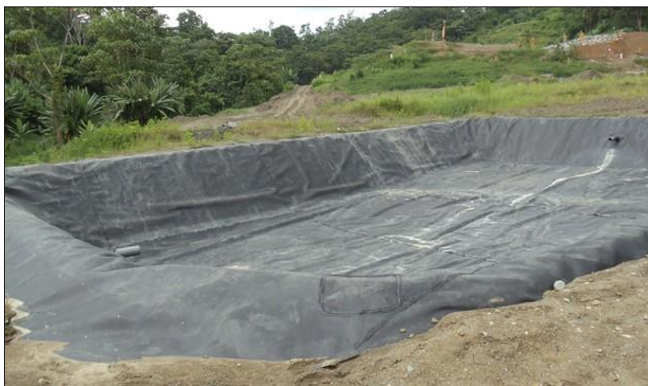
Fig 4. Sedimentador en construcción.
