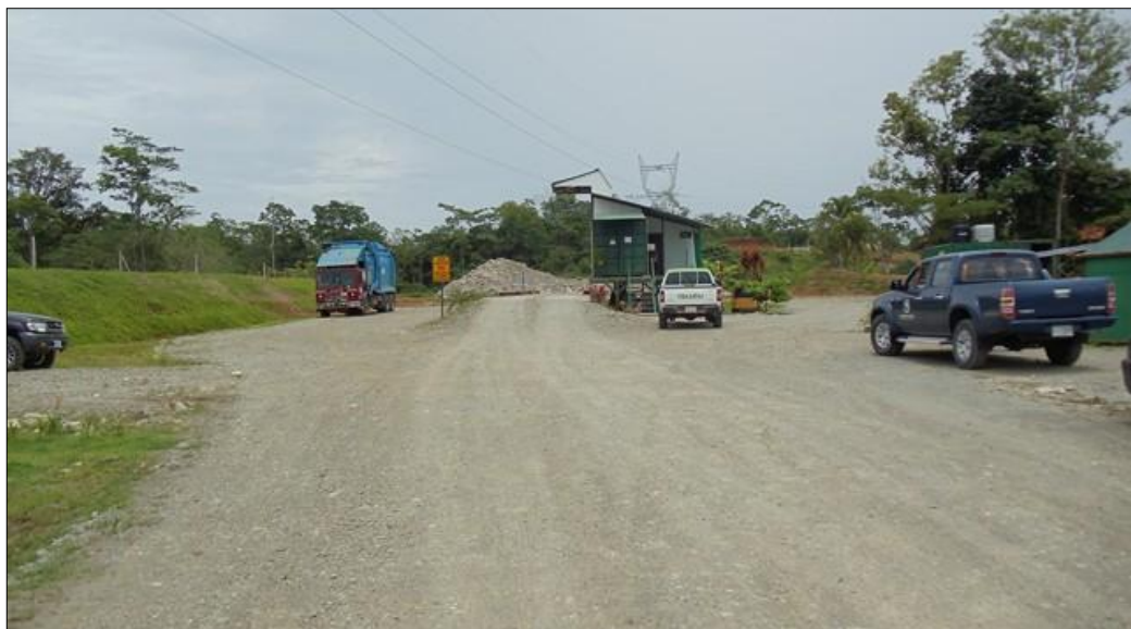
Fig 2. Caseta de control de pesaje de camiones y caminos internos.
