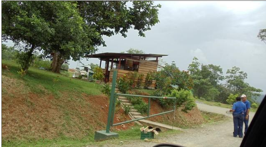
Fig 1. Caseta de control, entrada al relleno.
