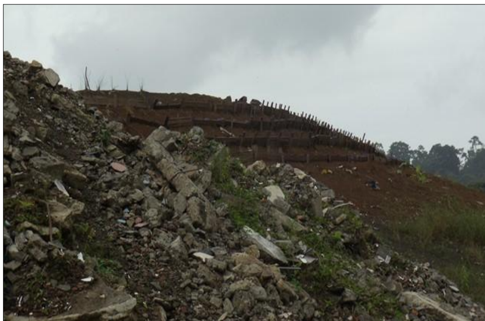
Fig 6. Talud con control de erosión.
