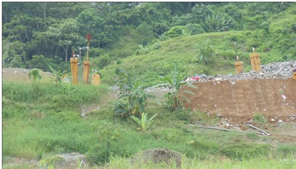
Fig 7. Chimeneas en el relleno.
