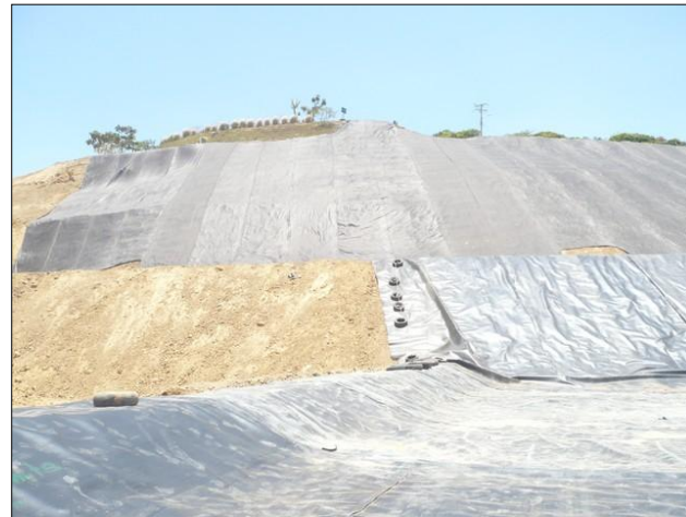
Fig 8. Celda en construcción.
