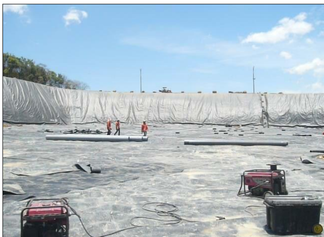
Fig 7. Celda en construcción.
