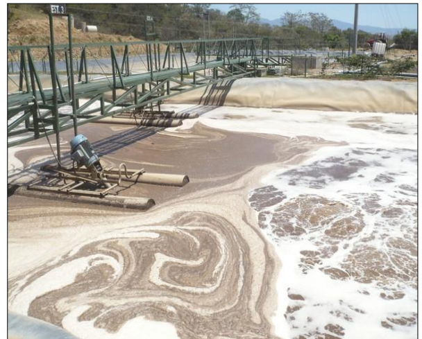
Fig 4. Laguna de lixiviados.
