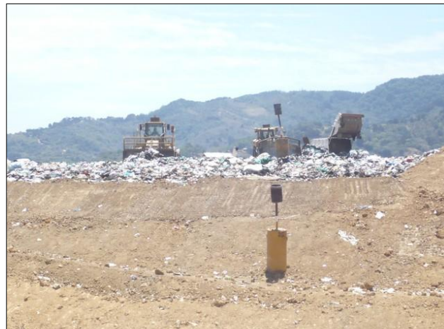
Fig 6. Chimenea cerca de la celda.
